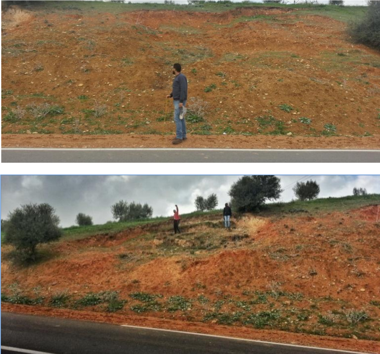
Figure 4 : Exemples de glissement de terrain sur pente le long du tracé actuel.
