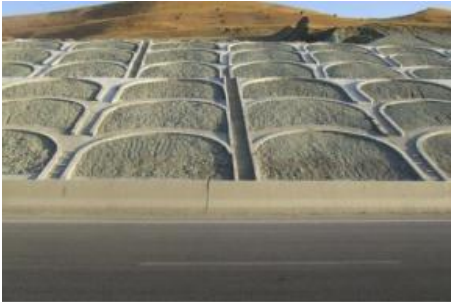
Figure 9 : La figure montre un exemple d'arcades avec fossés bétonnés.
