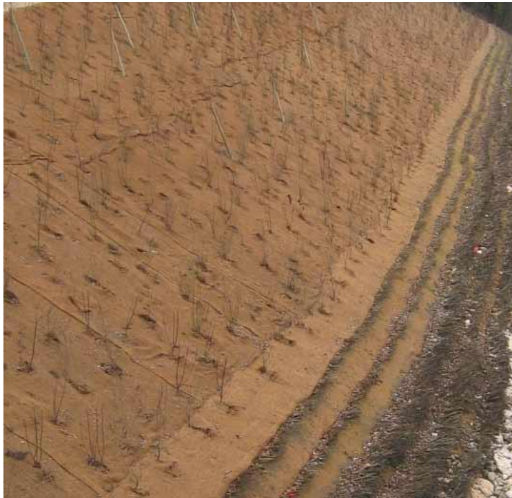
Figure 10 : La figure présente un exemple de boisement de talus antiérosif à recommander.
